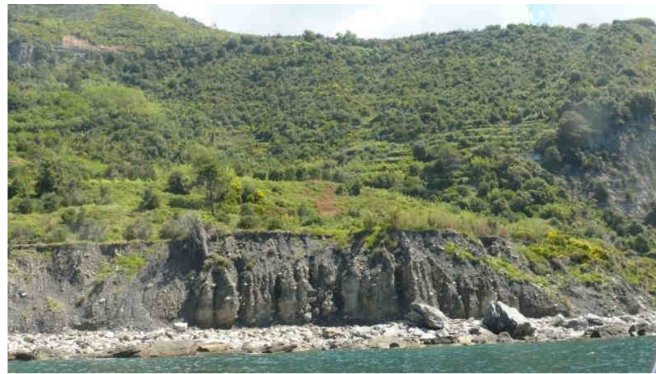
scalzamento al piede del'accumulo ad opera del moto ondoso
